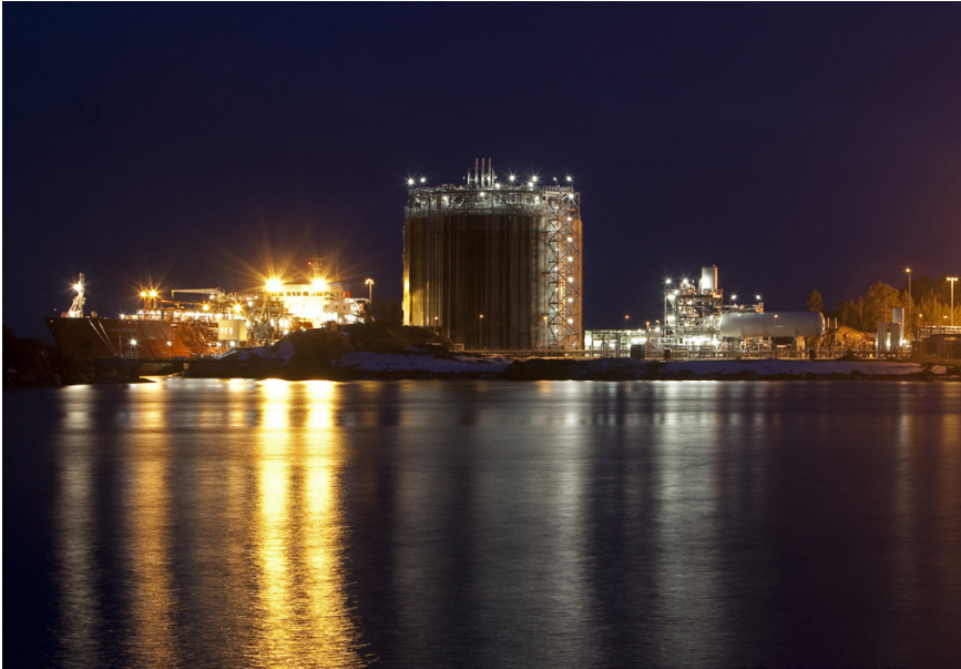
The LNG terminalen in Nynäshamn.
